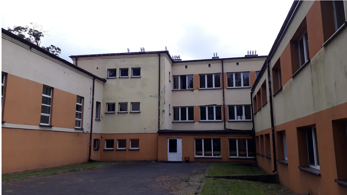
WIDOK OD STRONY POŁUDNIOWO - ZACHODNIEJ_ INWENTARYZACJA – ZAKRES OBJĘTY ROZBIÓRKĄ
