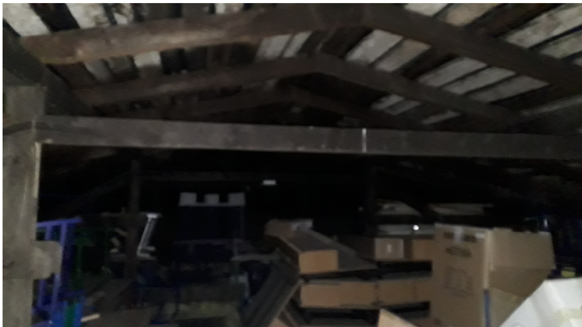
PRZESTRZEŃ STRYCHOWA – ELEMENT KONSTRUKCJI WIĘŻBY DACHOWEJ INWENTARYZACJA – ZAKRES OBJĘTY ROZBIÓRKĄ
